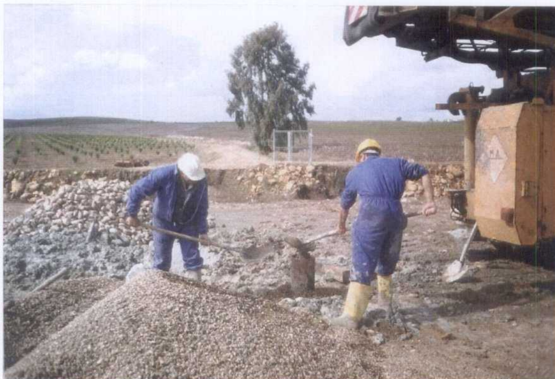
Colocación del prefiltro y acabado del piezómetro
