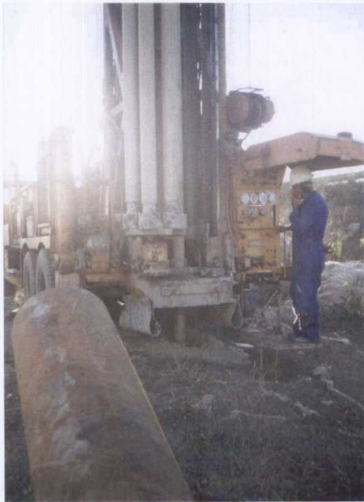
Perforación del taladro
