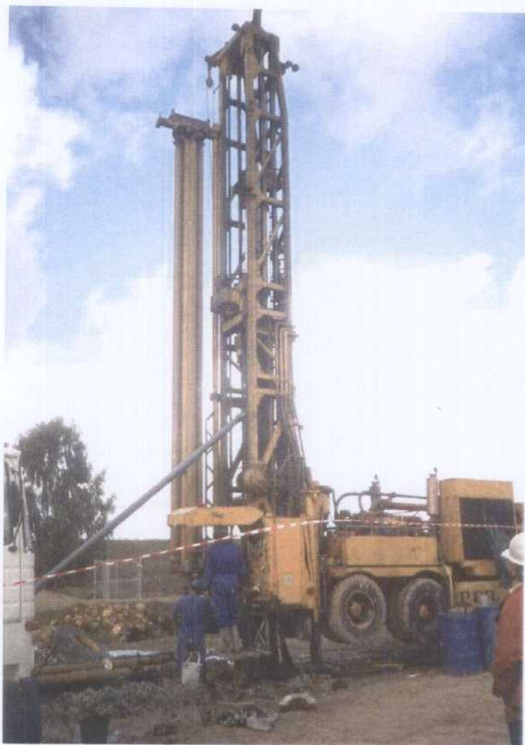
Instalación del piezómetro
